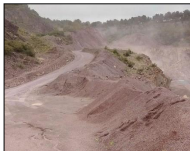
Enrochements et merlons de protection en place
