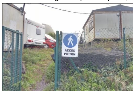
Porte de service d'accès aux locaux et clôture
