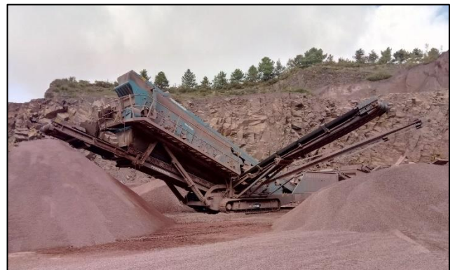
Crible et stocks-piles de matériaux traités
