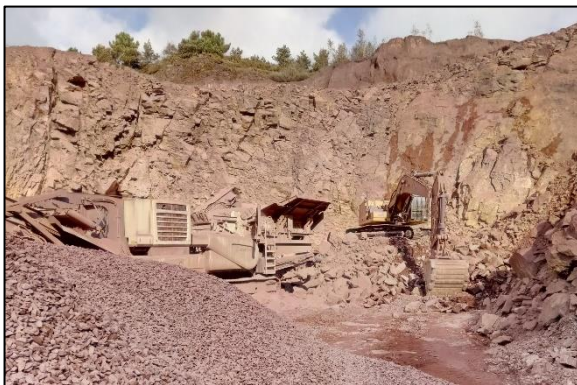
Opérations de marouflage à la pelle excavatrice et concasseur primaire
